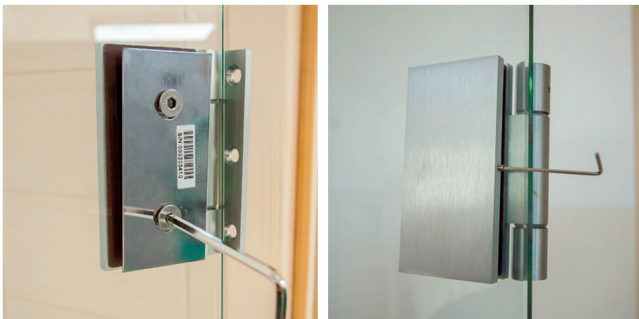
Fig. 32: Montaggio delle cerniere della porta 2
