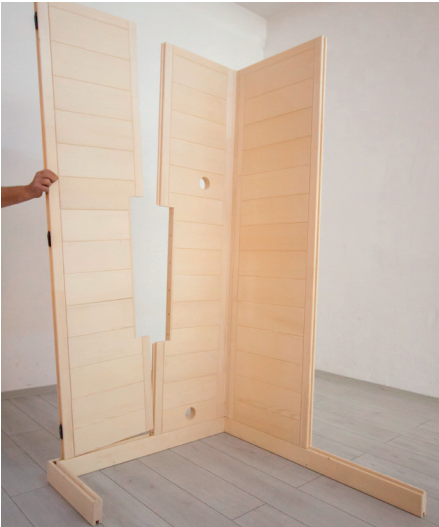
Fig. 6: Inserimento dell'elemento parete con intaglio
