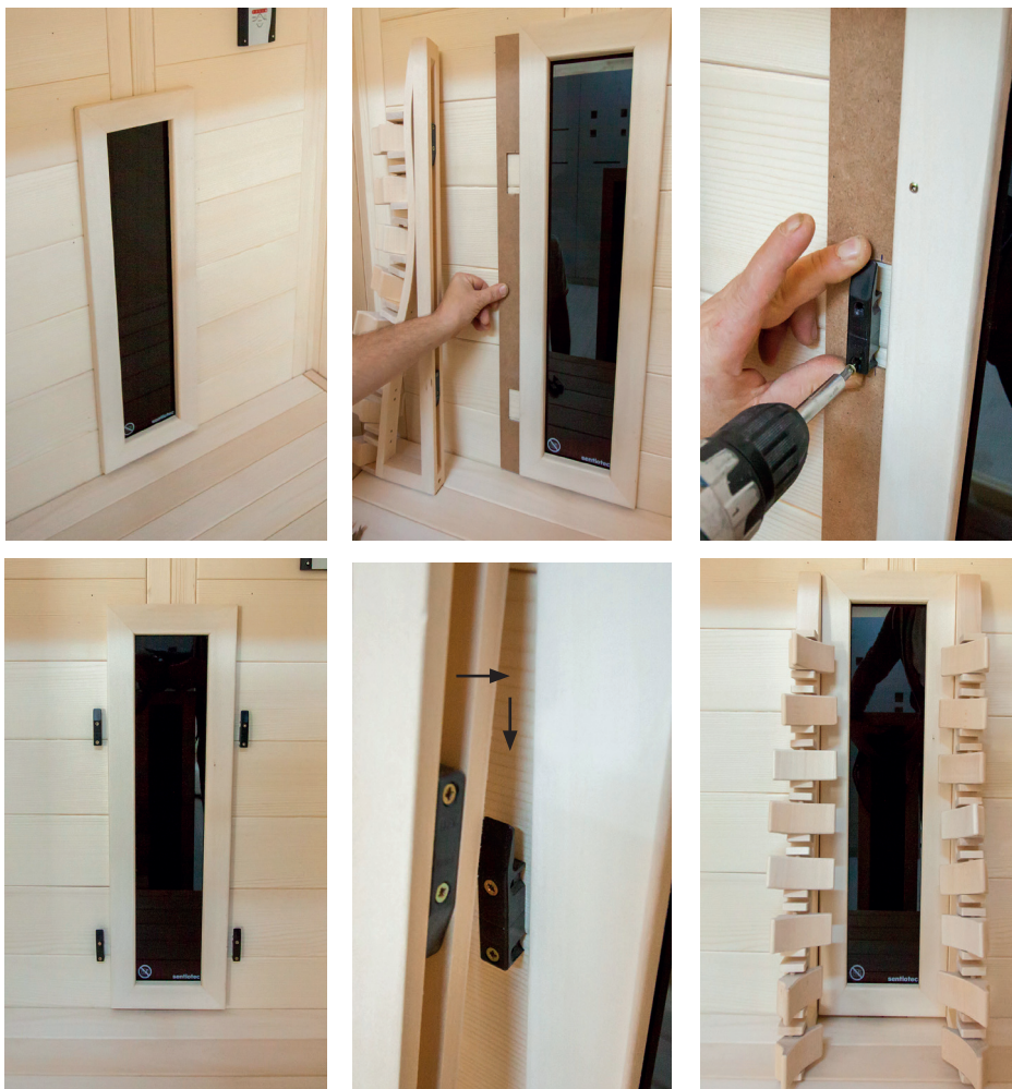
Fig. 29: Montaggio degli schienali
