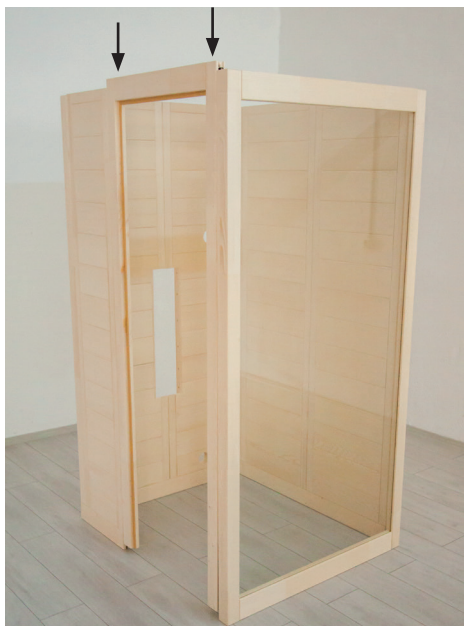
Fig. 10: Montaggio del telaio della porta
