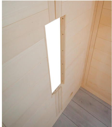
Fig. 6: Inserimento dell'elemento parete con intaglio
